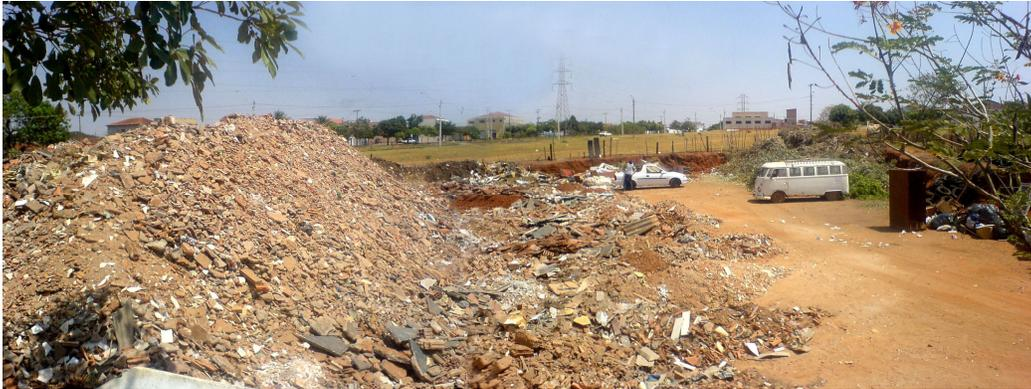
**f) exemplo de Aterro de RCD classe A – NBR 15.113/2004**
