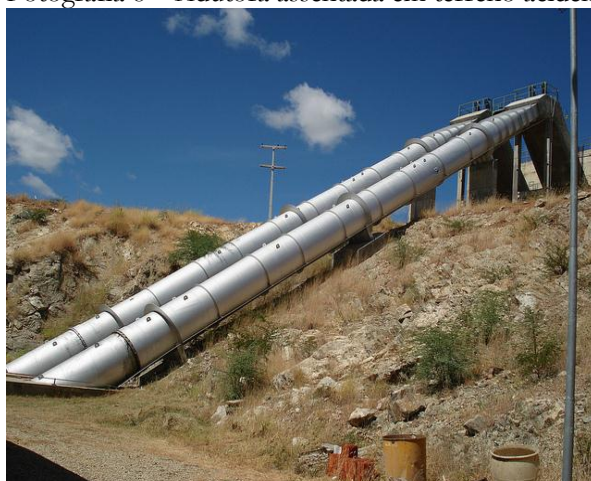
Fotografia 8 – Adutora assentada em terreno acidentado
