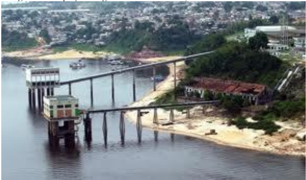
Fotografia 5 – Captação de água na Ponta do Ismael, Manaus – AM
