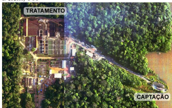
Fotografia 4 – Captação de água no lago Bolonha, Belém/PA
