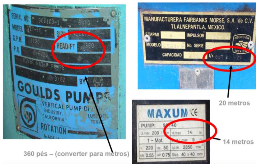
Figura 3 – Exemplos de consulta da altura manométrica na placa da bomba
