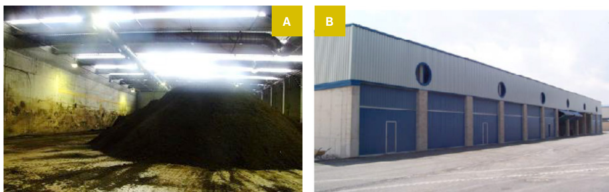
Figura 7: Instalações de compostagem das Usinas de Tratamento Mecânico Biológico Ecoparc II [A] e Ecoparc La Rioja [B], localizadas na Espanha
