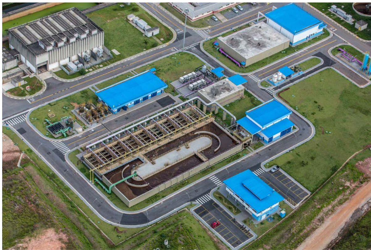
FIGURA 41. AQUAPOLO – VISTA DAS INSTALAÇÕES
