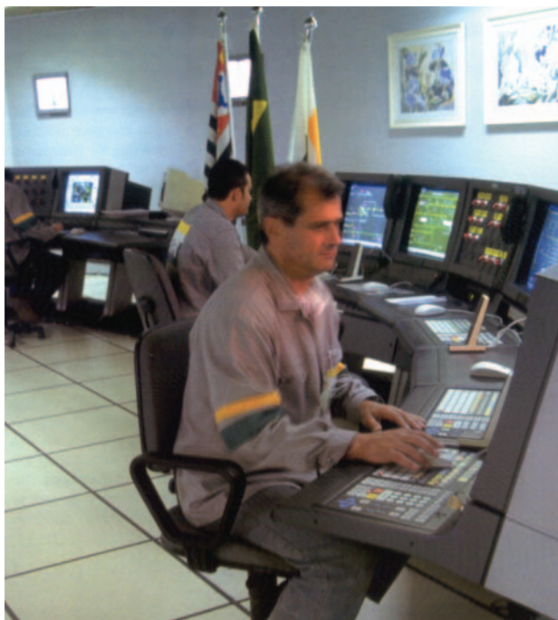
Centro de Monitoramento
