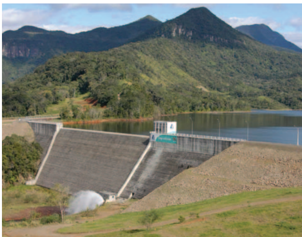
Barragem São Bento – SC
